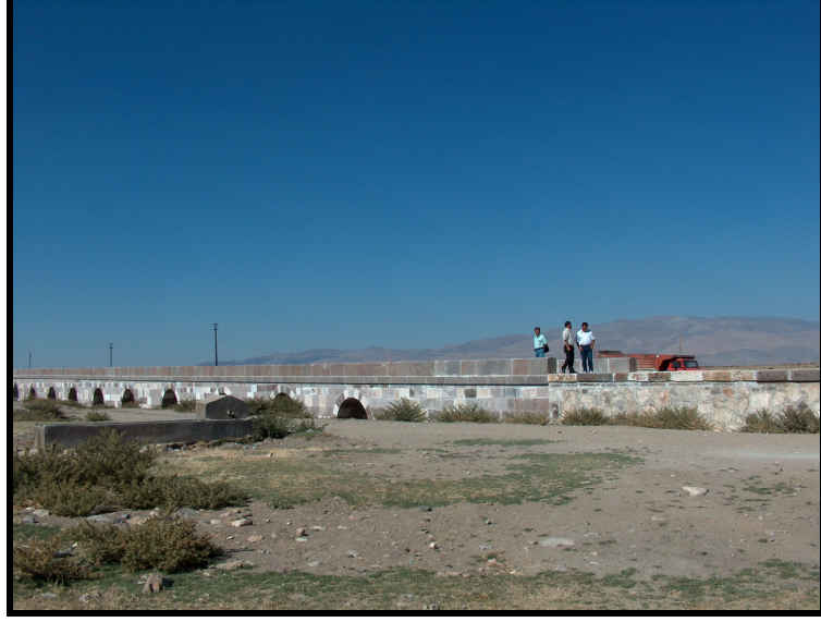
Fotoğraf 1: Bolvadin ile güneyindeki Çay ve diğer yerleşmeler arasındaki bağlantı, Selçuklular döneminde Kırkgöz ile sağlanmıştır. Günümüzde asfalt yolun hemen yakınındaki bu tarihi köprü 2004 yılından beri restore edilmektedir.
